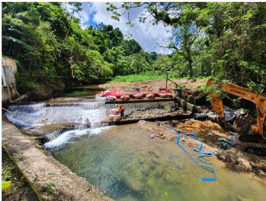
photo d'un batardeau en rive gauche pour effectuer des travaux sur une prise d'eau
